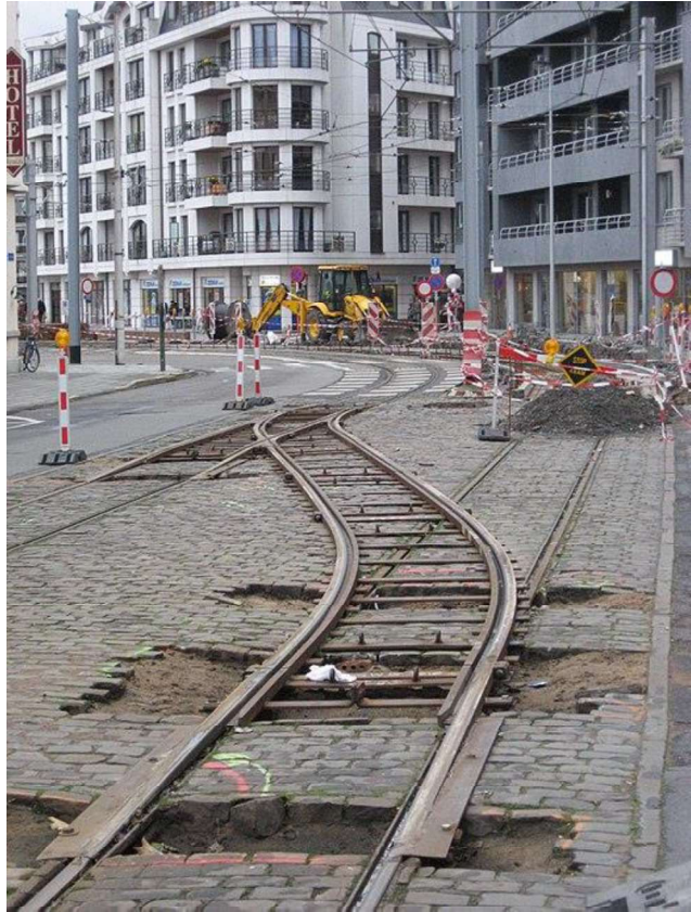
Figuur E.4 Een oplegwissel wissel (Wikipedia, 2008)
