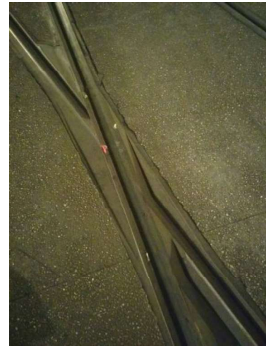
Figuur 2.15 Sprong in groefdiepte (Constantin, 2016)
