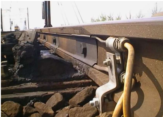
Figuur 2.3 Elektrisch lintelement (Wikipedia, 2010b)
